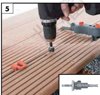
5 之後，不需要鑽孔模版即可完成鑽洞及穿孔。穿孔的深度可利用筒型鑽來精準放置。(料號：0650 700 400)
