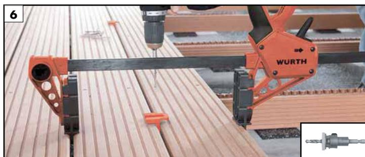
6 當整個木板皆打洞完成，於中心固定木板中到支撐托梁。木質建設的螺絲鉗也能輕鬆的用來撐開或者彎曲木板。
