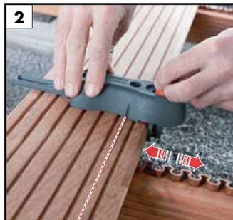
2 將鑽孔模版放置於標註記號的上面，調整後方鑽孔精確對應的標記線。
