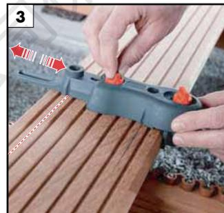
3 同樣地，利用一旁的記號調整前方鑽孔對應的標記線。之後確實的將木板放置於支撐托梁。
