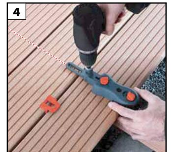
4 在木板間每80公分放入間格圈。利用標記將鑽孔模版對齊於螺絲行，之後可以直接開始進行鑽孔。
